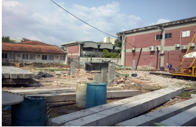
Figura 12: Reforma do laboratório de Engenharia Química (LEQ)
