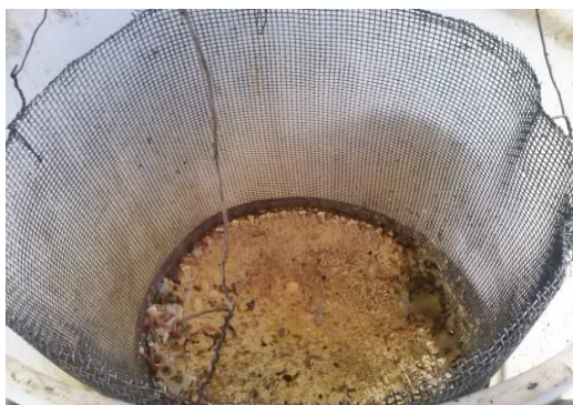
Figura 4.7: Sistema de Peneiramento com a retenção de Resíduos sólidos grosseiros.
