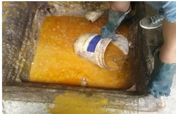
Figura 4.1 - Coleta do Material Residual Gorduroso das Caixas de Gordura do RU-UFPA. Fonte: O autor.
